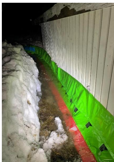
Bruk av flomvern Harstad
